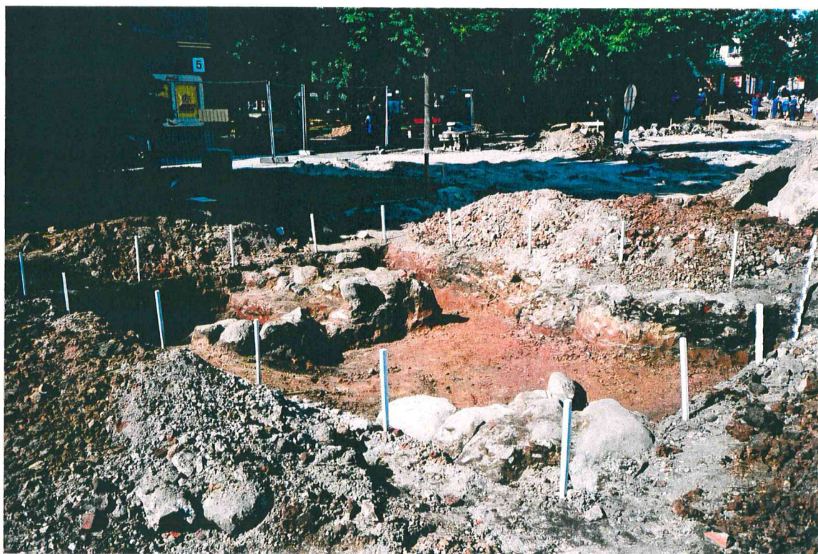
14. Bendras 4 – os perkasos vaizdas iš šiaurės rytų pusės, 45 - 50 cm gylyje, nuėmus betono plokštes, smėlio dangą rekonstrukcijos metu. Panevėžys. 2007 m.
