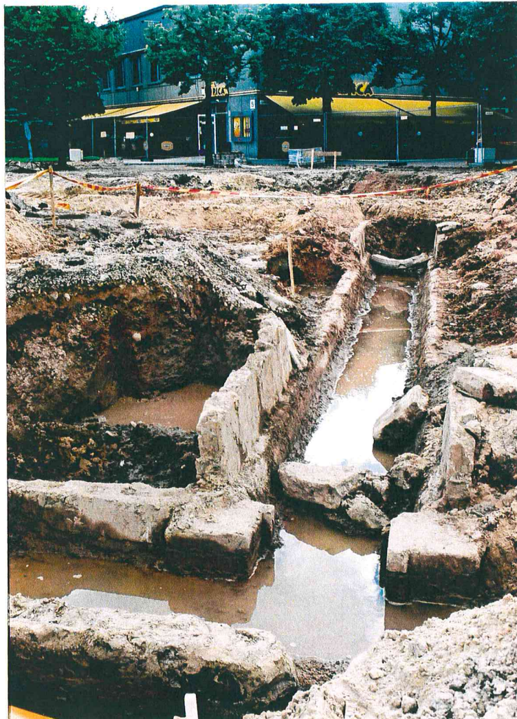
12. Laisvės aikštėje atidengta suardyto seno vandentiekio dalis (išlikęs betoninis lovys), vedantis link Ukmergės gatvės. Panevėžys, 2007 m. Foto iš šv pusės.
