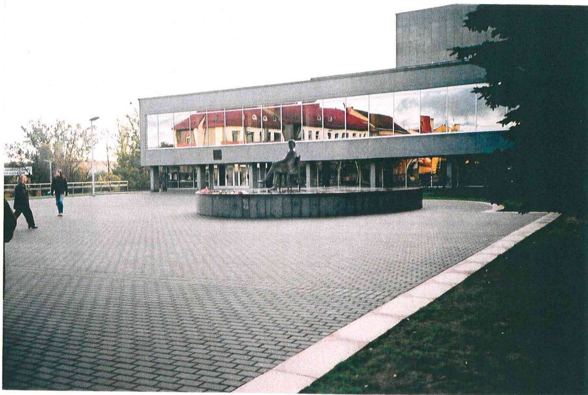
19. Panevėžio Laisvės aikštės šiaurinės dalies bendras vaizdas po rekonstrukcijos 2007 m. Foto iš V pusės.
