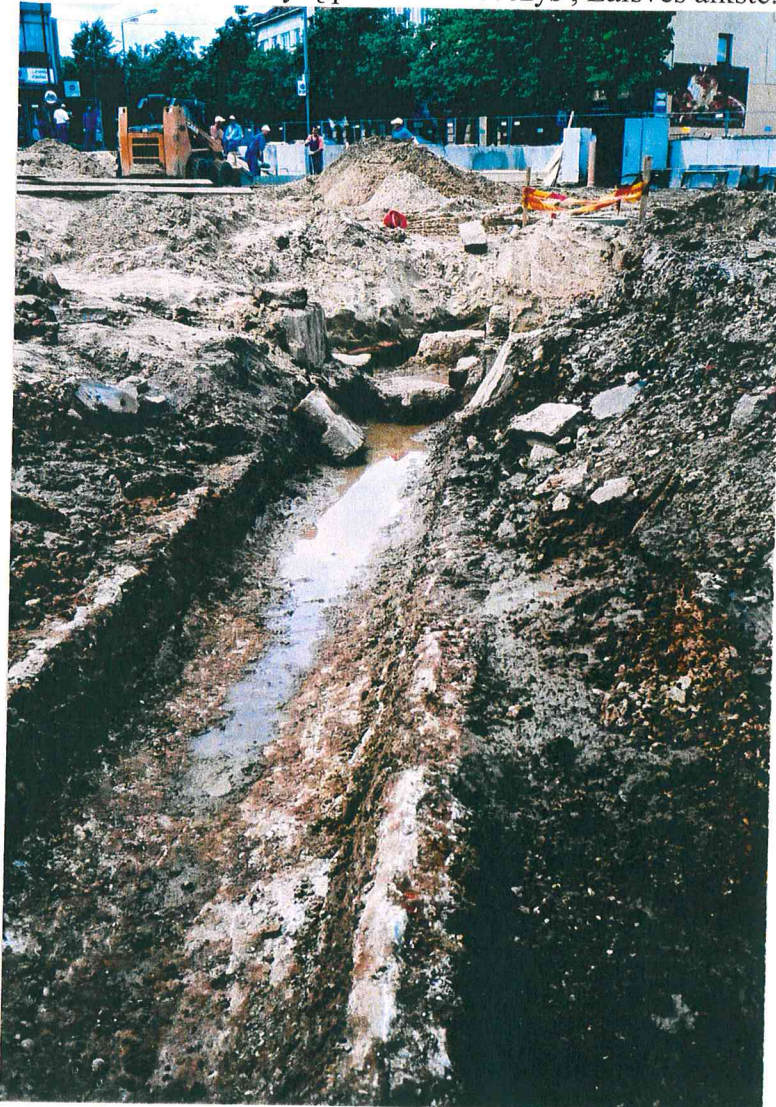
6. 3 – oji perkasa. Laisvės aikštės šiaurinėje dalyje atidengtas betoninis įrenginys vandeniui nutekėti ( išlikęs lovyis) . Vaizdas iš šiaurės pusės.2007 m.
